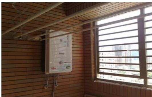
瓦斯熱水器圖示 1 (要通風)
