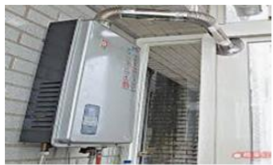
瓦斯熱水器圖示 2 (不通風，要排風)
