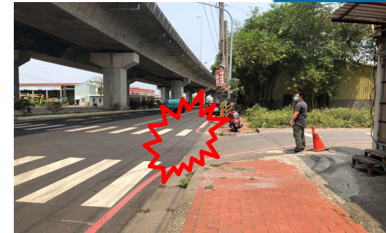
110.03.05上午 大社區和平路1段853-1號巷口
