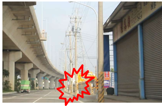
102.01.19夜 和平路二段201-7號巷口號前電桿
